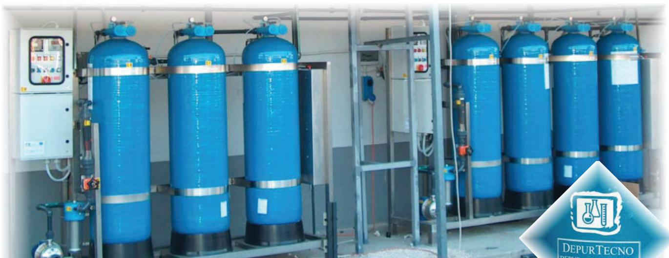
Los instrumentos para medir la conductibilidad del agua con los que están equipadas las plantas, realizan las funciones de medición e indicación. El agotamiento de las resinas está señalado automáticamente por el aumento de la conductibilidad. Alcanzando los valores límite predispuestos, acciona señales luminosas o acústicas, puede detener filtros o desviar el flujo del agua a una planta conectada en paralelo.
